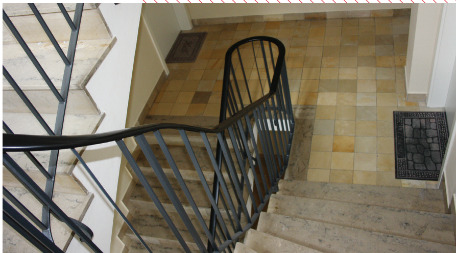
Im Treppenhaus dürfen keine Gegenstände abgestellt werden.
