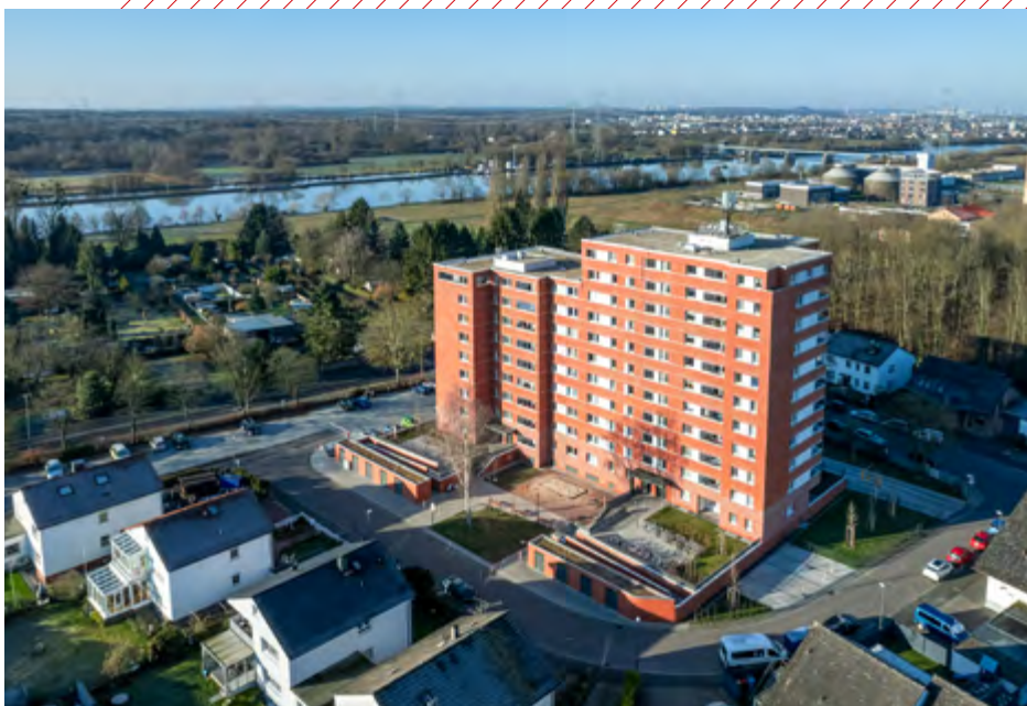
Die Philipp-Reis-Straße 1-3 konnte am Tag der Architektur besichtigt werden
