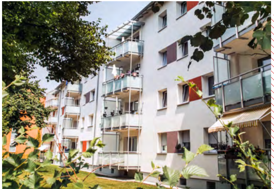
Sanierte Wohnungen der Baugesellschaft Hanau GmbH
